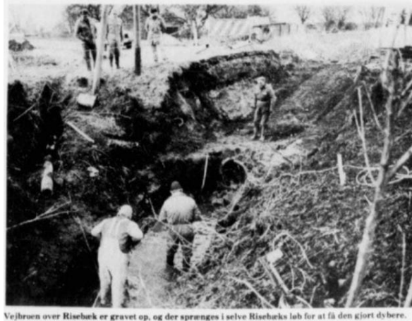
Figur 4-1 Sprængning under Risebæk, /7/
